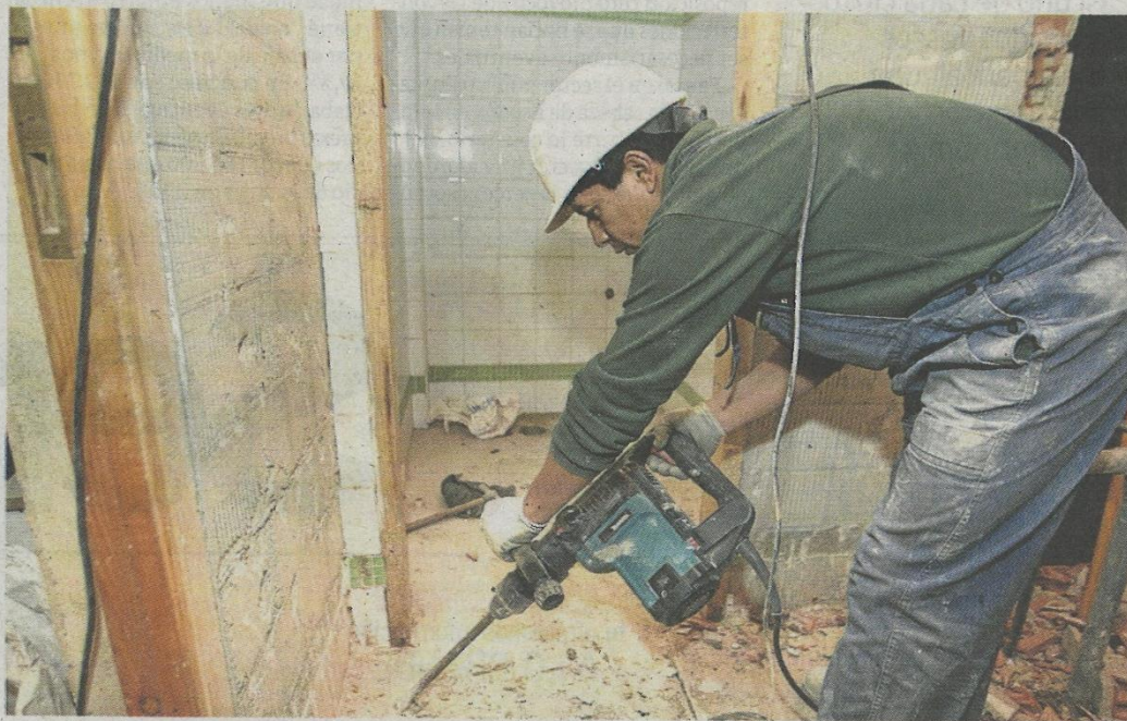
Un trabajador durante la reforma de una vivienda, un sector con alto nivel de autónomos. ■ AVELINO GÓMEZ
